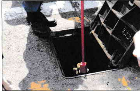
蓋を開いたらスピンドルドライバーを差し込みます。蓋の倒れ防止にも
