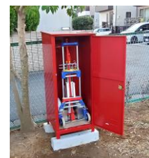
（写真）下小川公園に新設したスタンドパイプ消火資機材格納箱（赤箱）と格納の様相
